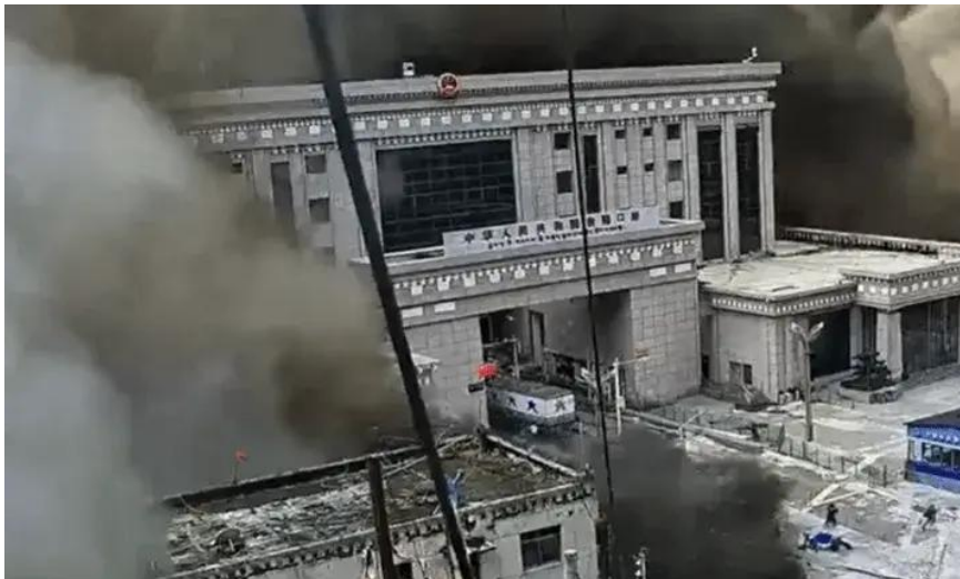
Imatges de circuit tancat de televisió (CCTV) de la inundació que va destruir el pas fronterer de Gyirong. Font: Wikipedia
